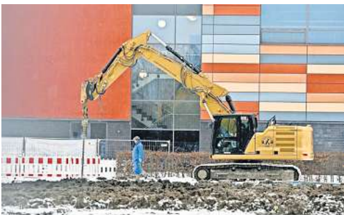
Die Suche nach Bomben läuft wieder: Sondierungen auf dem Göttinger Schützenplatz.
